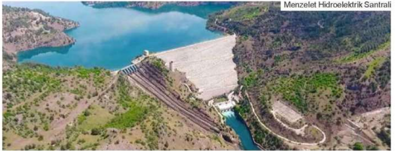
Menzelet Hidroelektrik Santrali
